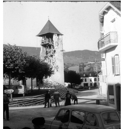
Le clocher de l'église d'Arette après le séisme de 1967 (archives de la mairie d'Arette)
